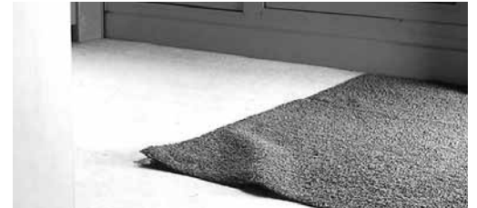
Bild 5: Hochstehende Teppichkanten können z. B. mit Leisten gesichert werden.
