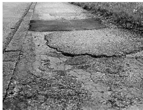
Bild 3: Mangelhaft ausgebessertter Belag. Niveaudifferenzen sind möglichst klein zu halten.
